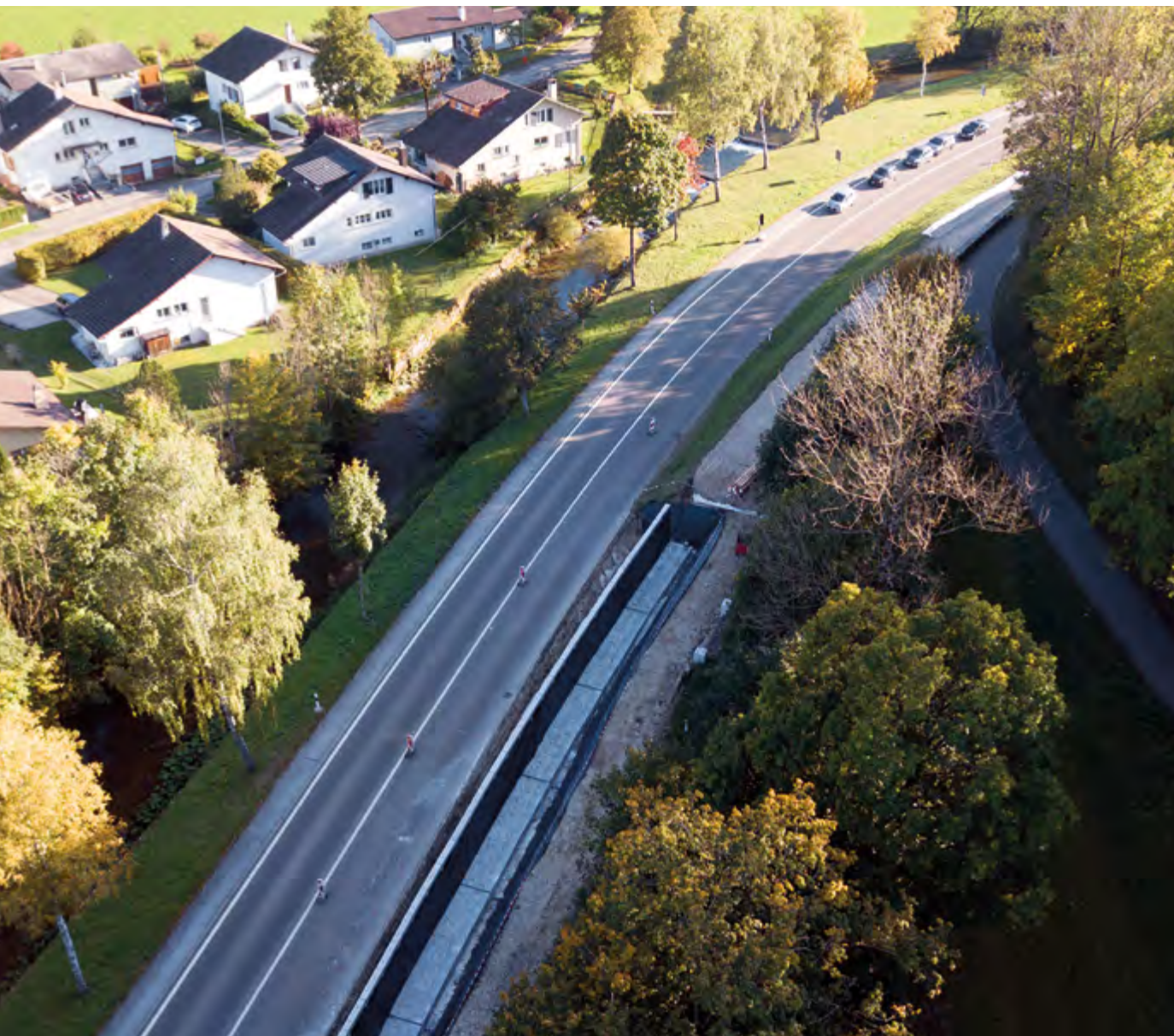
Renouvellement de la voie Fleurier - Buttes et construction d'un mur de soutènement
