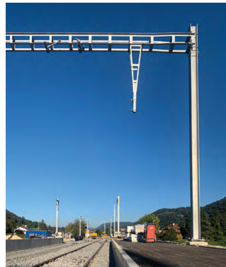
Renouvellement de la voie Fleurier - Buttes
